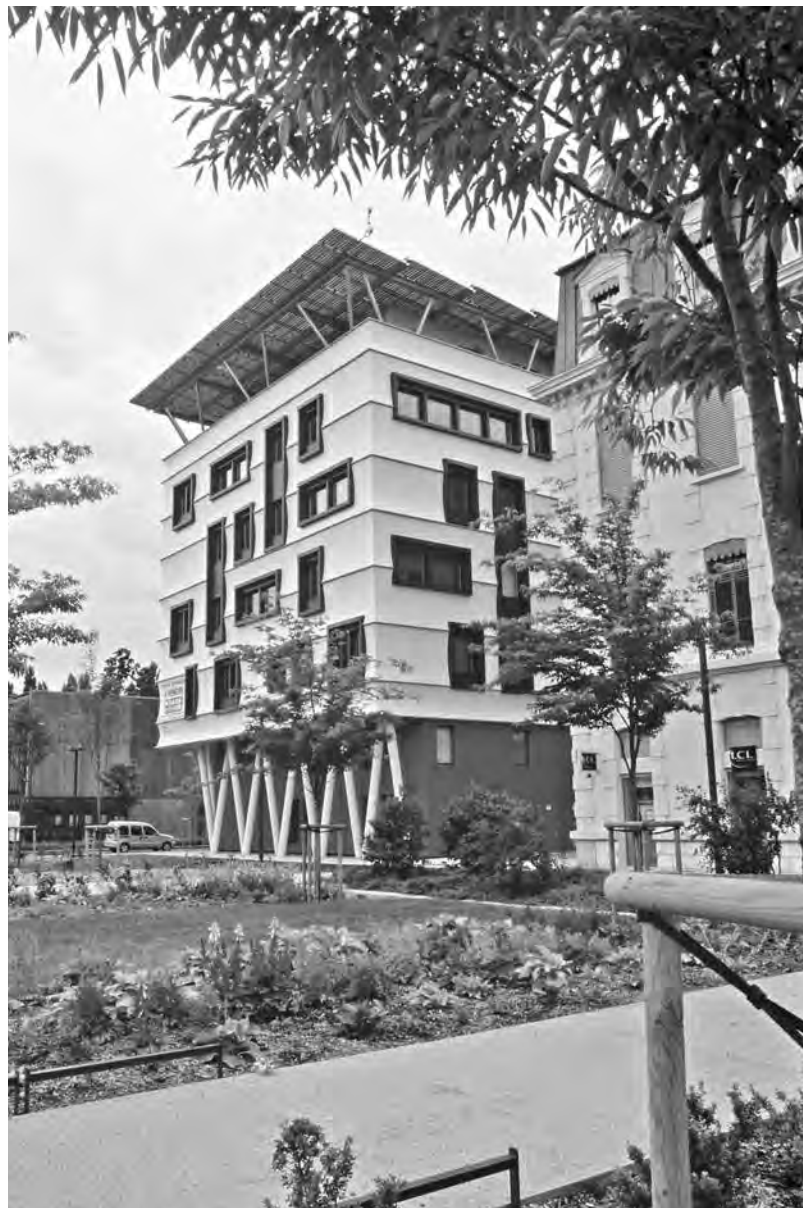
Un immeuble de bureaux de Grenoble conçu pour être à énergie positive. Il est situé dans l'écoquartier de la ZAC de Bonne.
