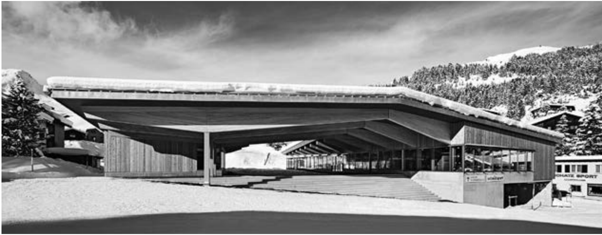
Die Parkgarage in Arosa zeigt, dass auch grosse Bauten aus Laubholz-Brettschichtholz möglich sind.
